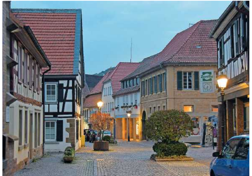
Historische Bausubstanz, die es zu hegen und zu pflegen gilt. Rockenhausen hat da einiges zu bieten. Doch nicht alles, was da im Zuge von Sanierungen getan worden ist, ist im Auge des außenstehenden und womöglich kundigen Betrachters auch gelungen.
