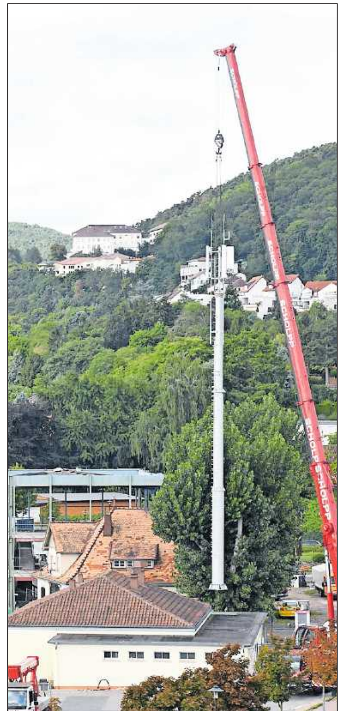
Ist nicht zu übersehen: Der Mobilfunkmast wird gerade aufgestellt. ARCHIVFOTO: FRANCK
